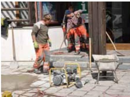
*Die bestehende, zu steile Rampe wurde entfernt und an deren Stelle wurden Stufen errichtet.*
