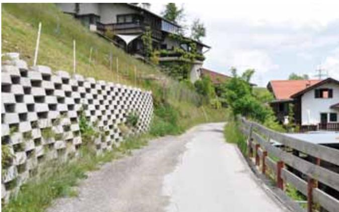
In der gleichen Art und Weise, also mit Böschungssteinen, soll der Ausbau bis hin zum Objekt Köhlgasse 13 erfolgen.
